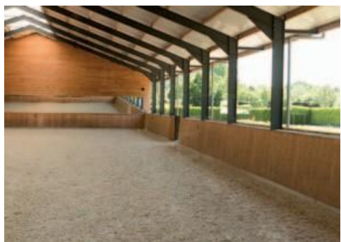
In der Reithalle gibt es viel Licht, weil eine Längsseite aus Fenstern besteht und die andere offen ist; ein Wunsch von Jonna.
